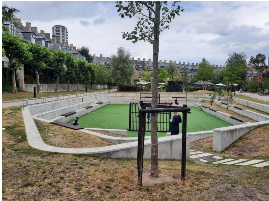
Figura 24. Distrito de Carlsburg.
