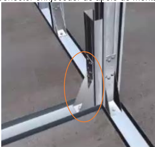
Figura 1 – Conector enrijecedor de apoio de montante na base
